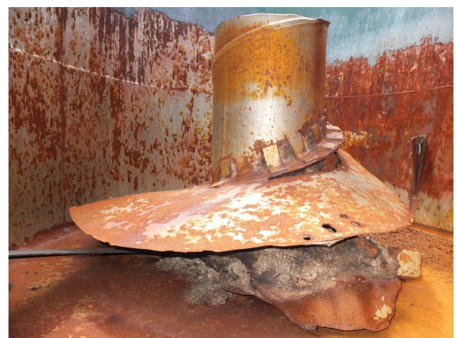
Abb. 19: Stark verschlissene Vertikalmischschnecke eines Feststoffvorlagebehälters aus Schwarzstahl (Foto: LfL).
