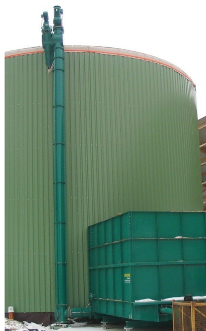
Abb. 14 und 15: Feststoff-Trocken-Eintragssysteme mit Trog-, Steig- und Stopfschnecke (Fotos: LfL)
