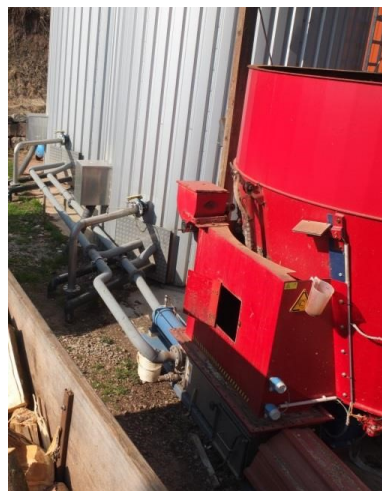
Abb. 17 und 18: Feststoff-Flüssig-Eintragssystem mit Exzentrerschneckenpumpe; SICHERHEITSHINWEIS: Vor Inbetriebnahme des Aggregats ist die Wartungsklappe zu verschließen (siehe Bildmitte)! (Foto: LfL).
