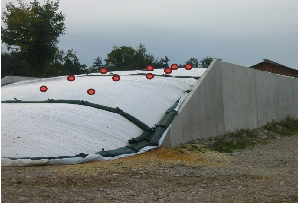
Abb. 4: Probenahme am Silo durch Einstiche von oben
