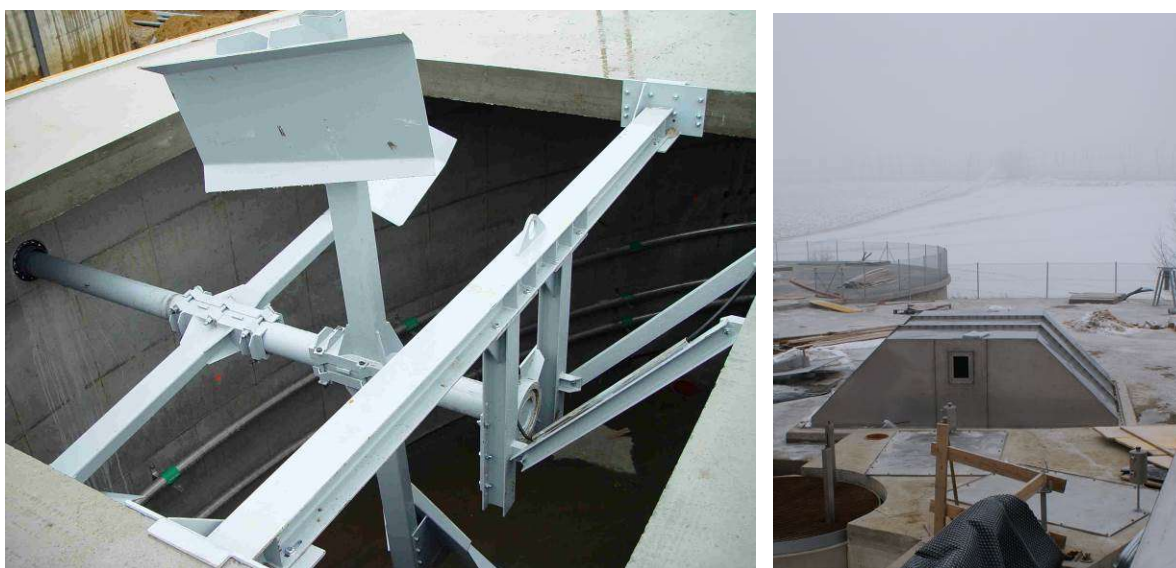
Abbildung 10: Sonderform eines horizontalen Paddelrührwerks mit Verankerung in der Betondecke (links) und Edelstahleinhausung (rechts)
