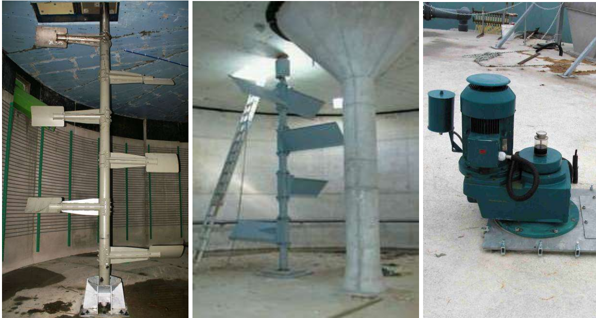
Abbildung 11: Vertikale Paddelrührwerke mit exzentrischer Anordnung und Antriebseinheit
