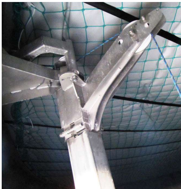
Abbildung 2: Seilzug und Schwenkeinrichtung an der Führungsstange eines Tauchmotorrührwerks
