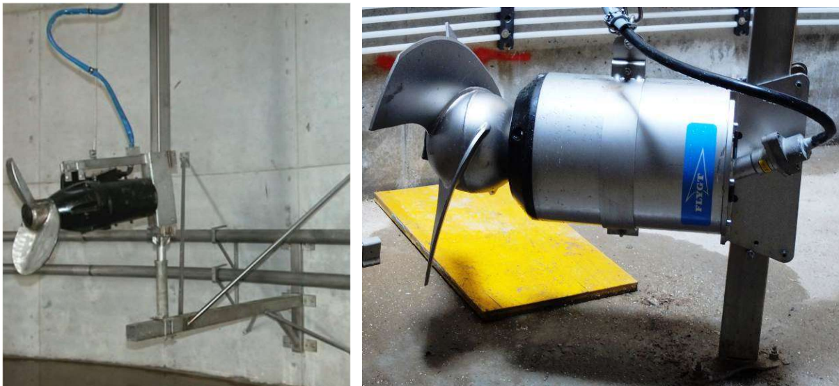
Abbildung 3: Schnell laufendes Tauchmotor-Propellerrührwerk mit Kabelführung am Tragseil
