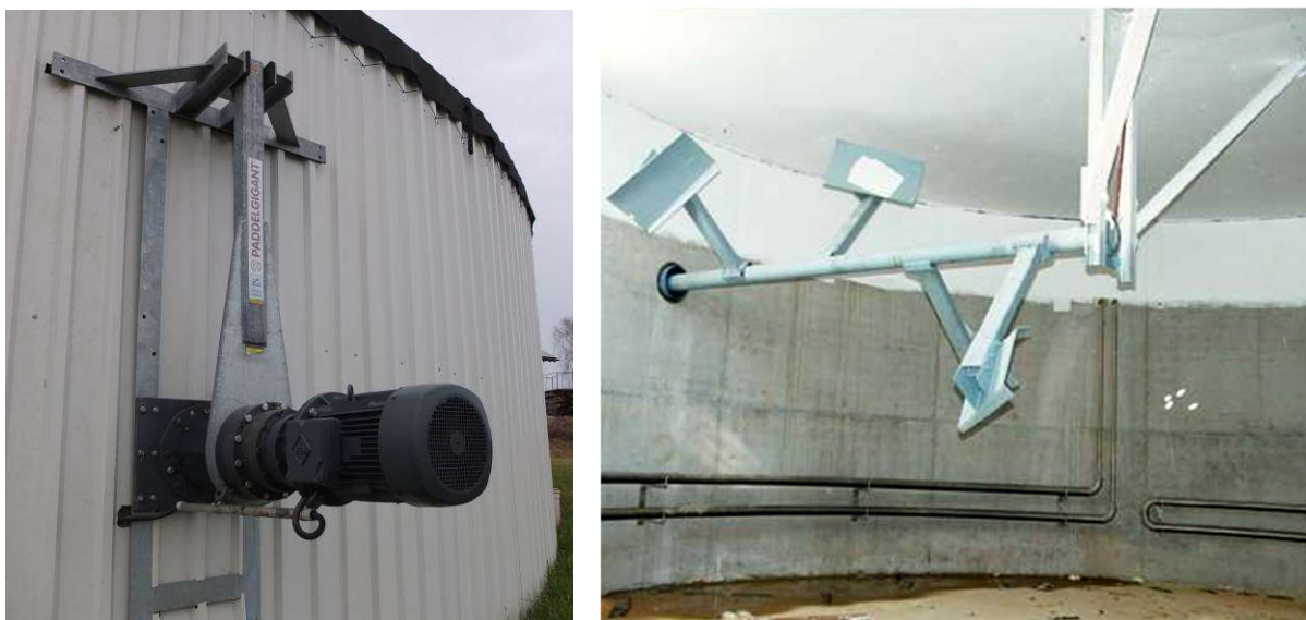
Abbildung 9: Hängendes horizontales Paddelrührwerk mit Antriebseinheit (Foto: LfL / agriKomp)
