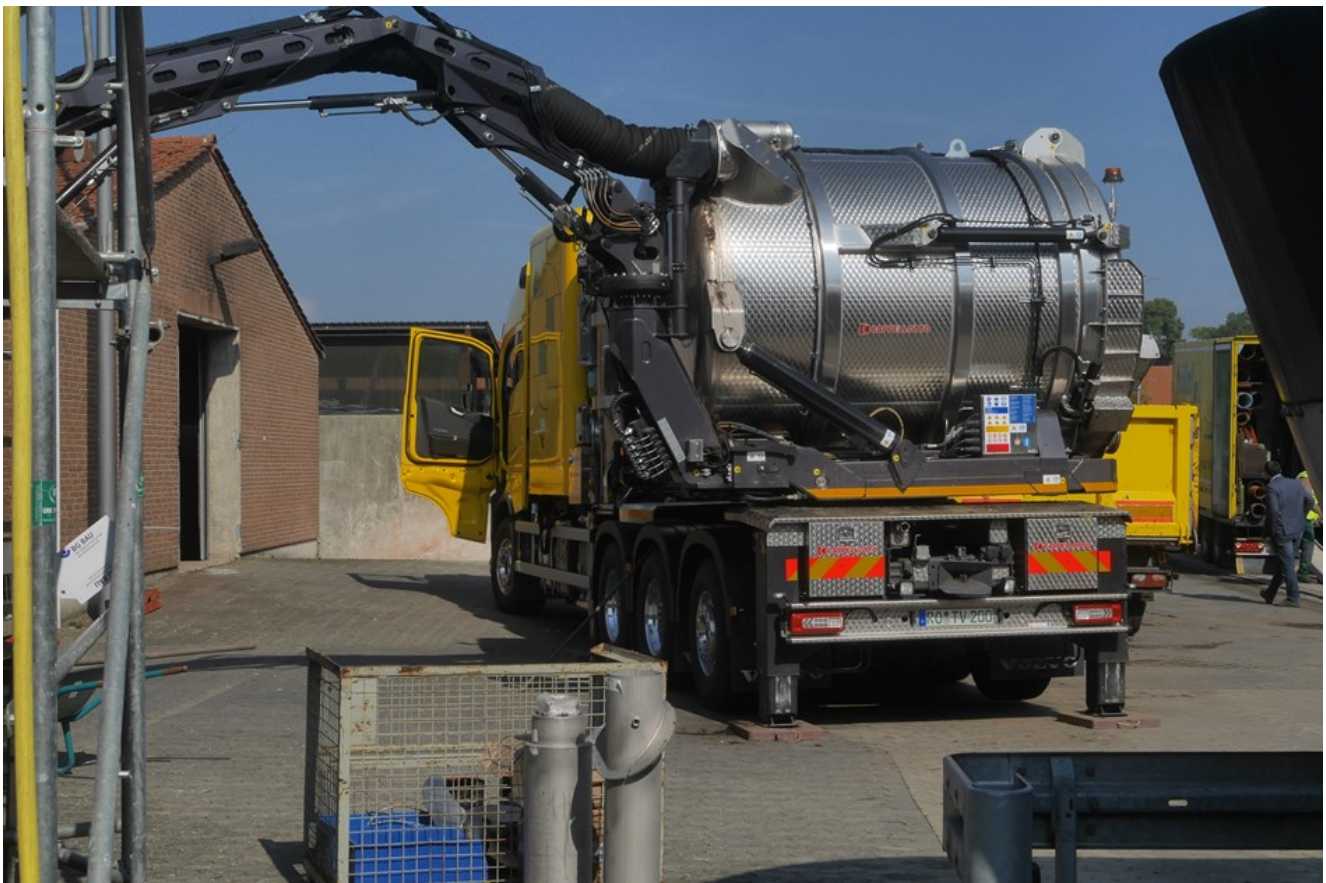
Abb. 1: Der Einsatz mobiler Hochleistungsauggeräte zur Entfernung der Ablagerungen im Gärbehälter erleichtert die Arbeit und minimiert die Entstehung von gefährlichen Gasen (Quelle: LLH).
