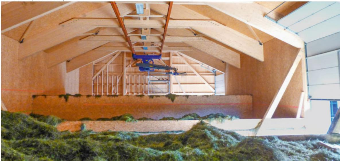
**Heubelüftungsanlage mit einem Hängedrehkran.** Für die Heubelüftung gibt es verschiedene Varianten.
