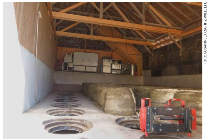
**Selbstzentrierende Rundballenluftauslässe** für variierende Ballengrößen einer hofeigenen Rundballenbelüftungsanlage.
