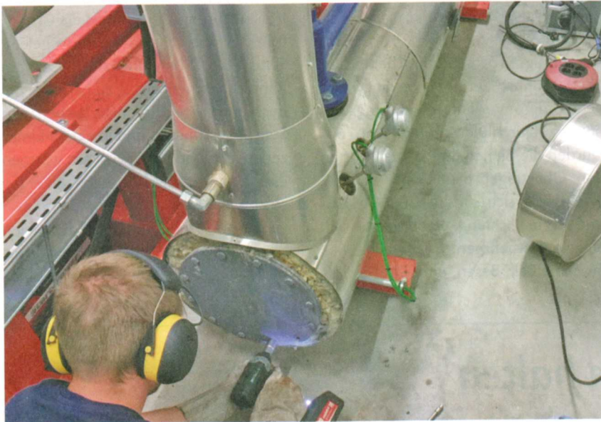
Installation eines Oxidationskatalysators im Abgastrakt eines Blockheizkraftwerks.
