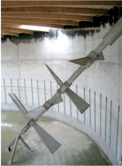
Langachsührwerk mit Decken- und Wanddurchführung der Rührwelle.
