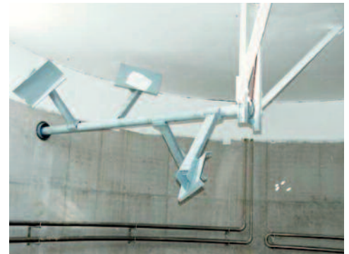
Paddelrührwerk mit horizontaler Welle.
