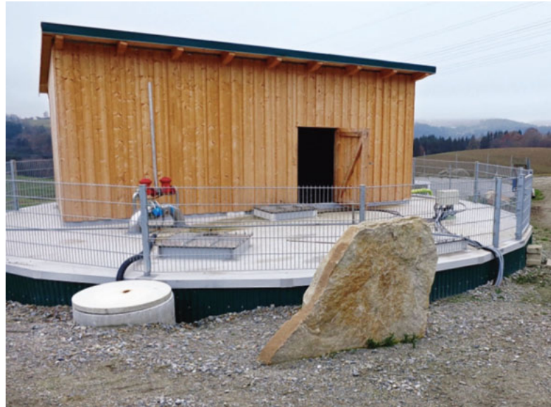
Kompakte Bauform: Unter gewissen Voraussetzungen können sich Biogasanlagen bis 75 kW lohnen.
